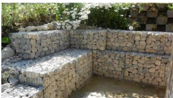
Simple à installer, le gabion permet de soutenir le talus à partir d'une structure métallique remplie de pierres, de roches. Il est durable et résistant dans le temps et ne nécessite pas d'entretien particulier.
