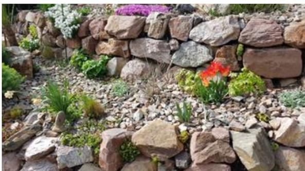
Pour stabiliser un talus, il est possible d'installer des pierres permettant un nivellement sur plusieurs étages. Cette solution apporte de nombreuses qualités paysagères au jardin. Il ne faut pas dépasser 1 mètre de dénivelé entre chaque niveau.
